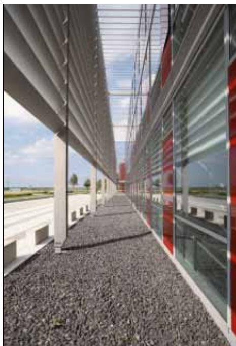
Plus la lamelle est grande, plus les distances pouvant être recouvertes en une fois sont grandes
