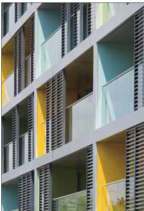
Outre leur fonctionnalité, les panneaux coulissants rendent la façade plus vivante ou plus moderne (dans la rénovation)
